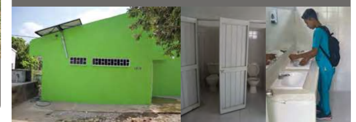
Nous avons rénové entièrement les toilettes et lavabos de l'école de San José à l'intérieur comme à l'extérieur. Elles sont désormais non mixtes et fonctionnelles.
